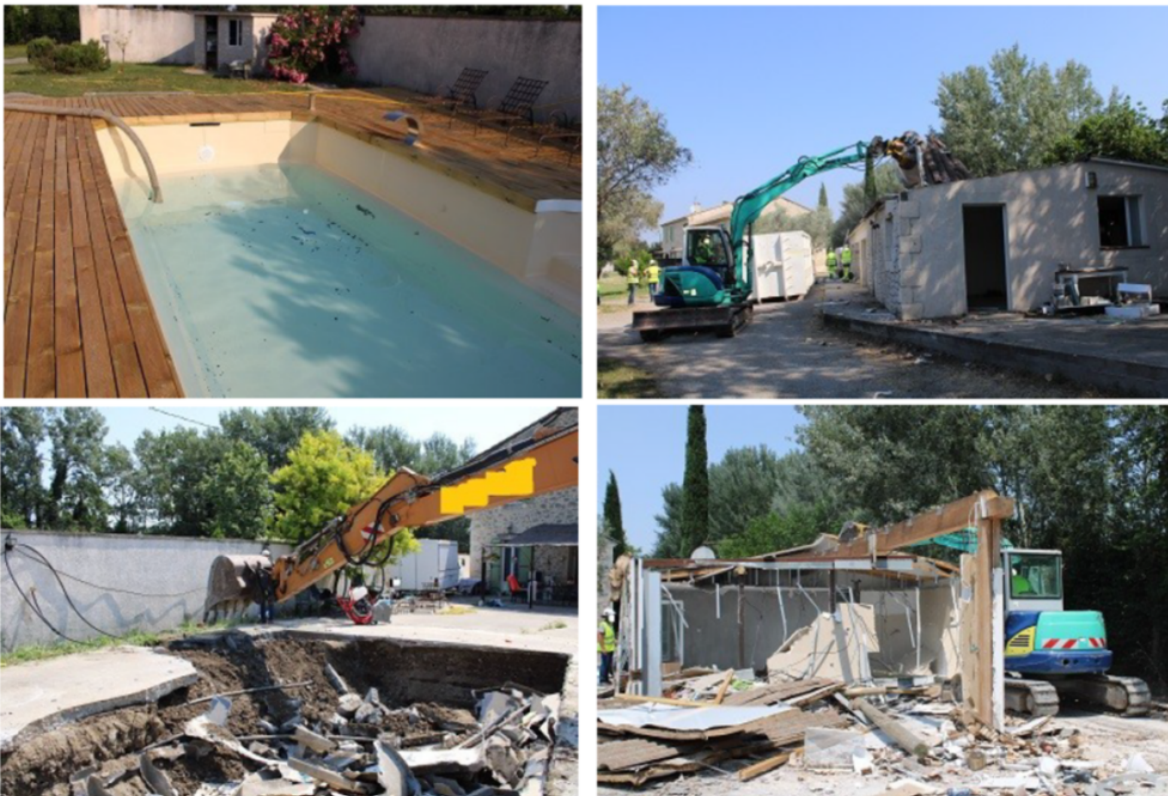
Opération de démolition d'une construction illégale à Avignon ordonnée par l'Etat en 2021. DR
