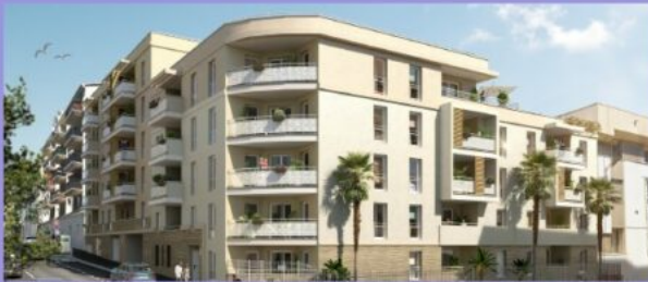
Rosa Nova - Toulon (83) 25 logements // Livraison 2028
