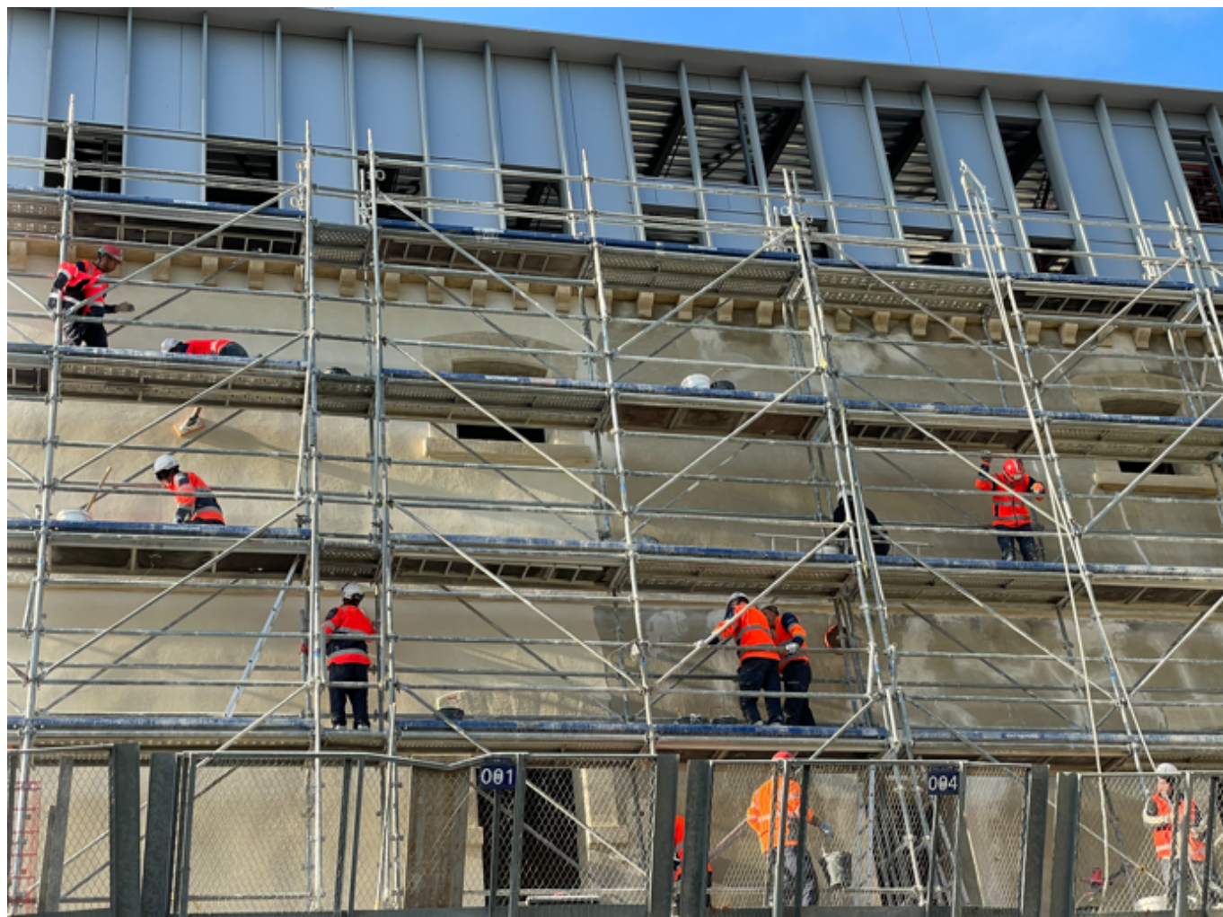
Le badigeon des façades
