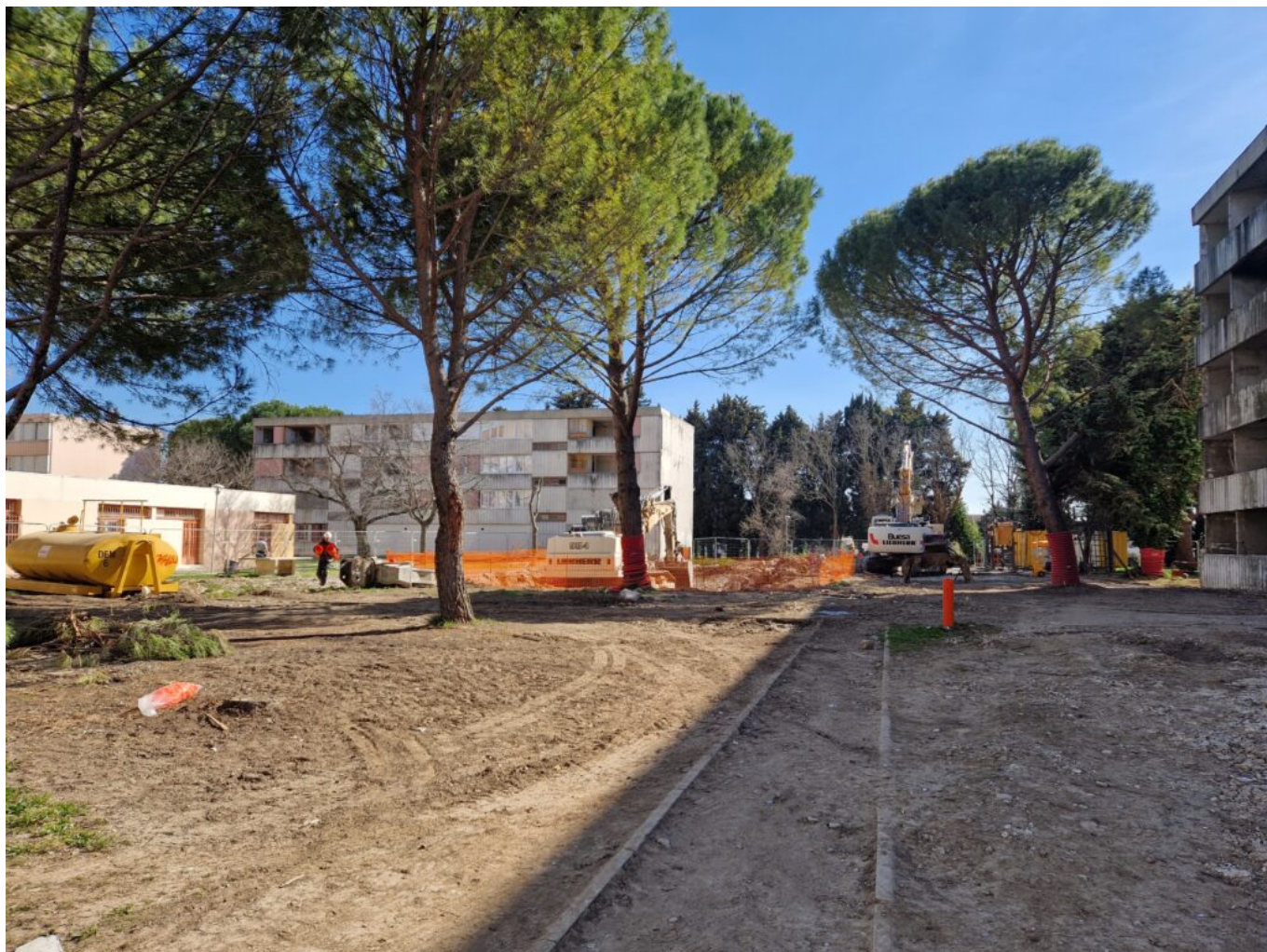
Le chantier en cours
