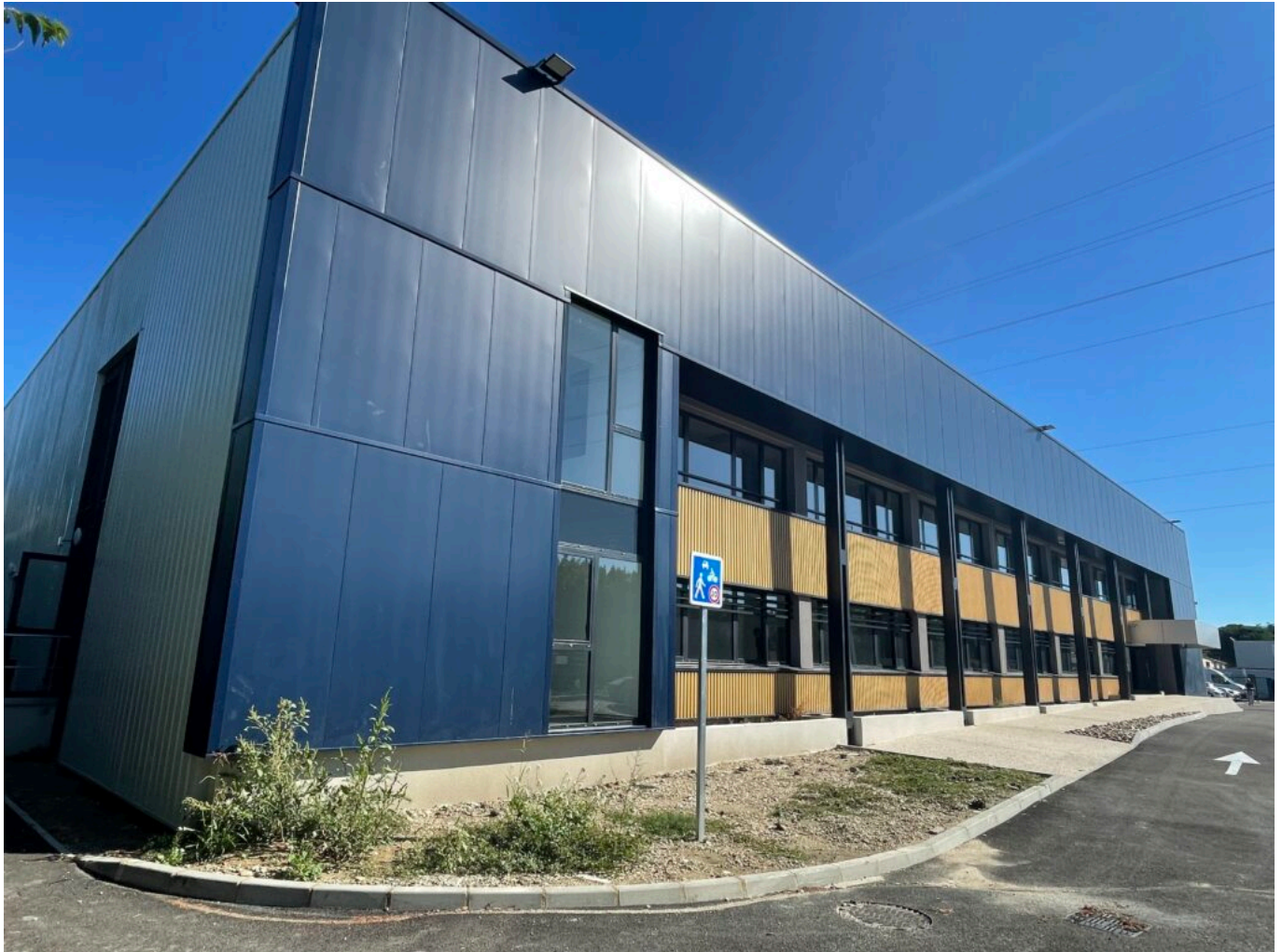
Montéa Bâtiment A, Courtine, Copyright MMH
