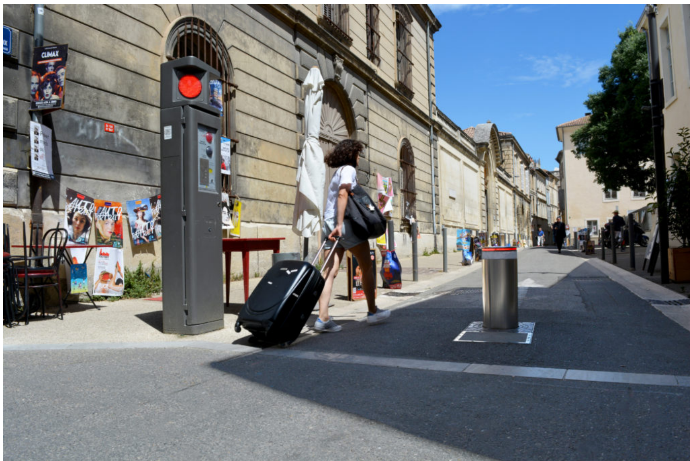
Système BES installé à Avignon
