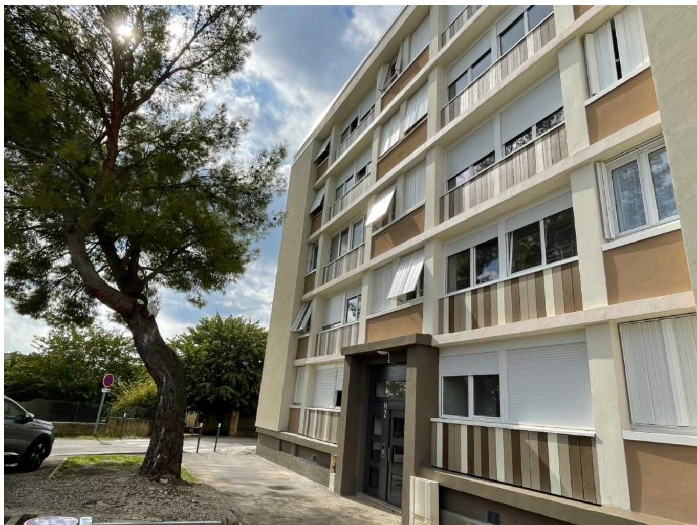
Batiment GDH réhabilité Copyright MMH
