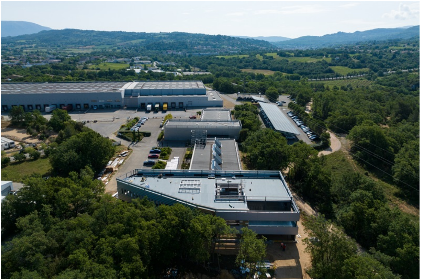
Le nouveau bâtiment est en bas de la photo. ©Delta Plus
