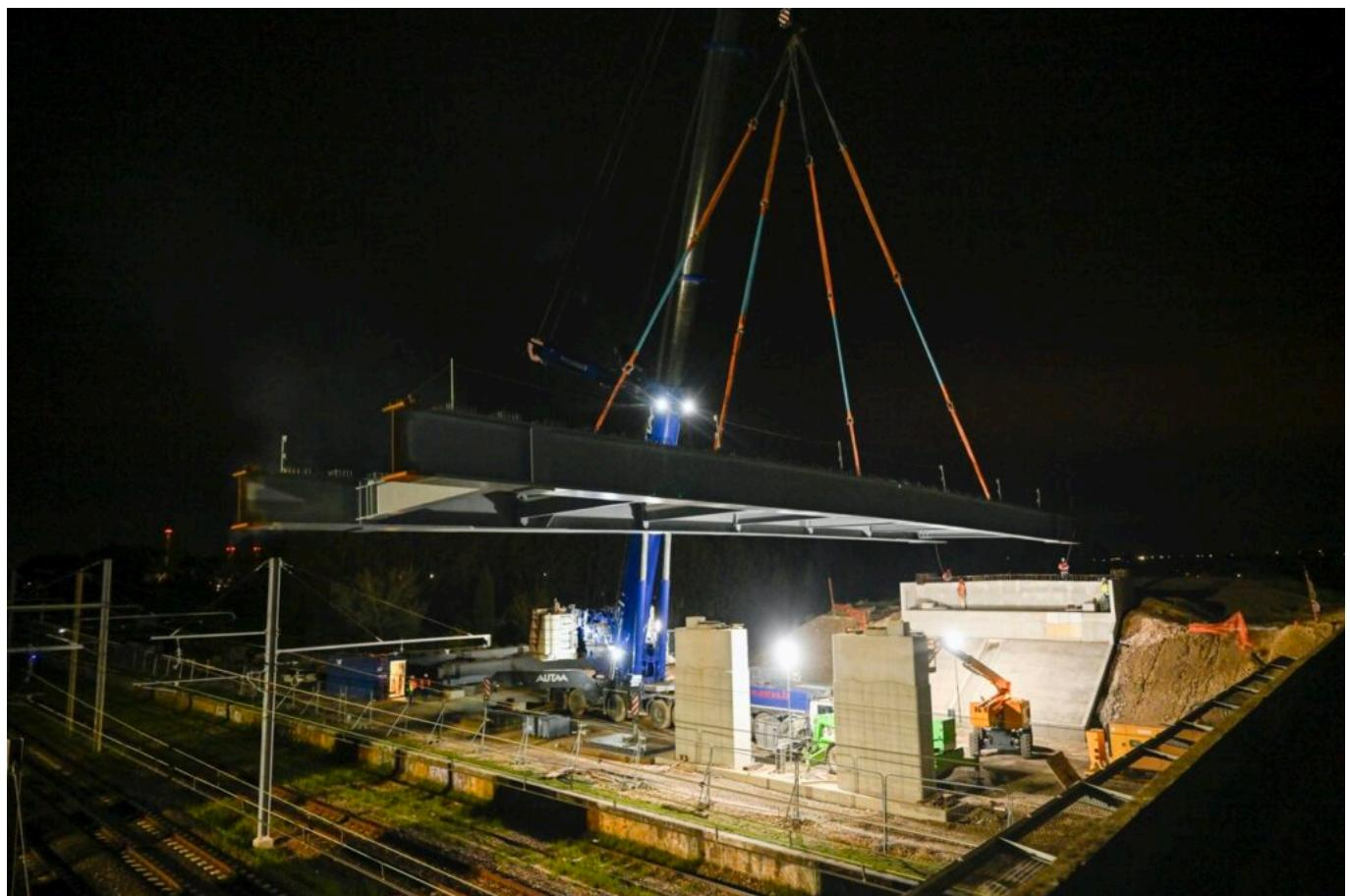
**Dans la nuit du mardi 2 avril au mercredi 3 avril, des travaux spectaculaires ont eu lieu sur le chantier de la déviation d'Orange puisque la charpente métallique du nouvel ouvrage franchissant la voie ferrée a été posée sur ses appuis grâce à deux grues. L'opération a nécessité une coupure totale de circulation des trains, programmée il y a trois ans avec la SNCF.**
