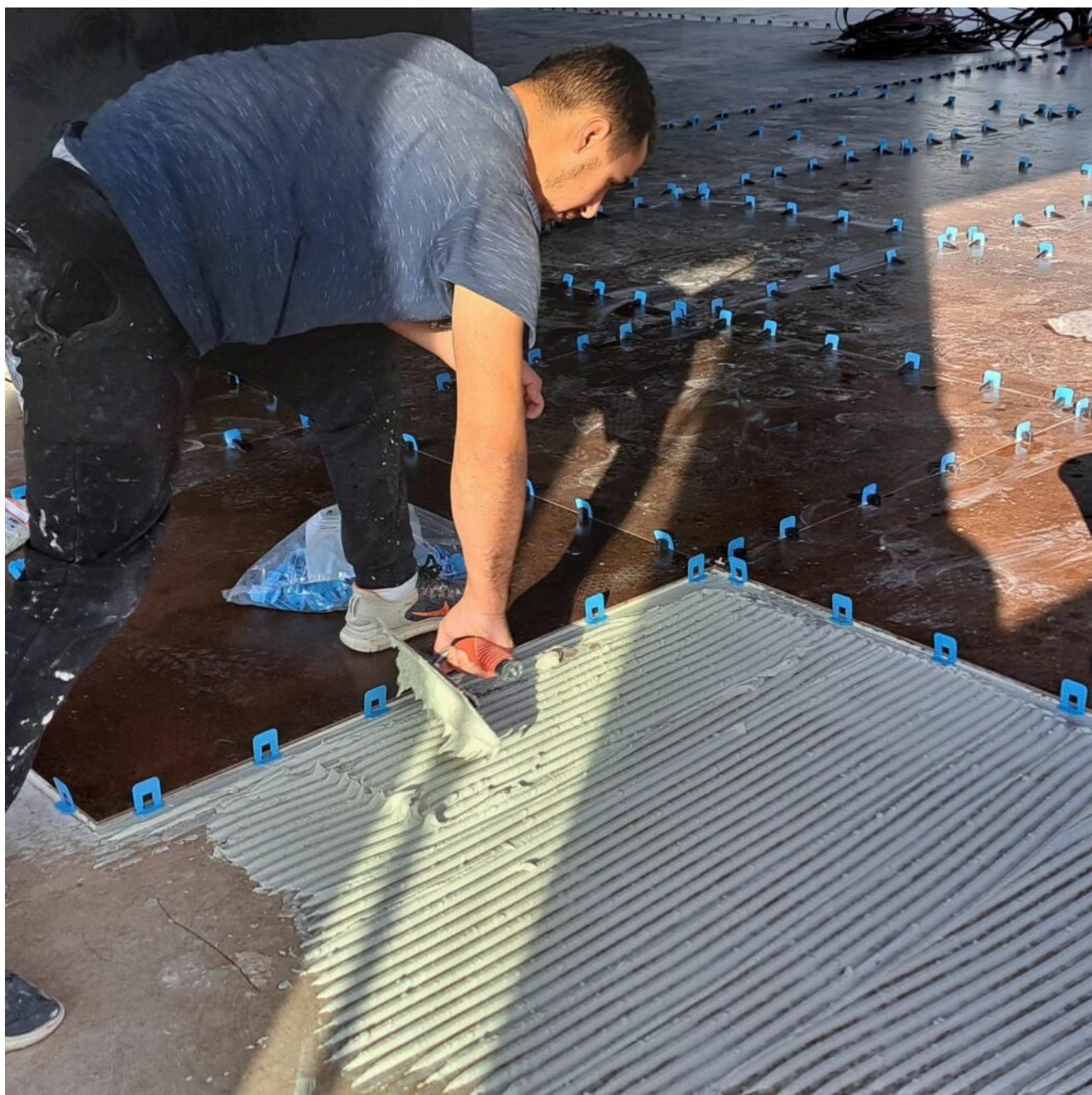
Pose du carrelage ©AB/L'Echo du Mardi
