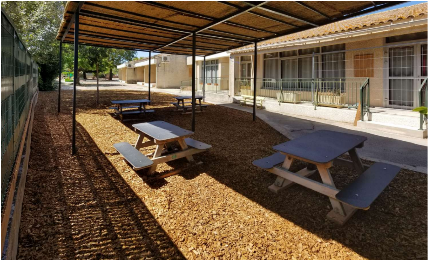
Ecole maternelle des Vallades Copyright l'Isle-sur-la-Sorgue
