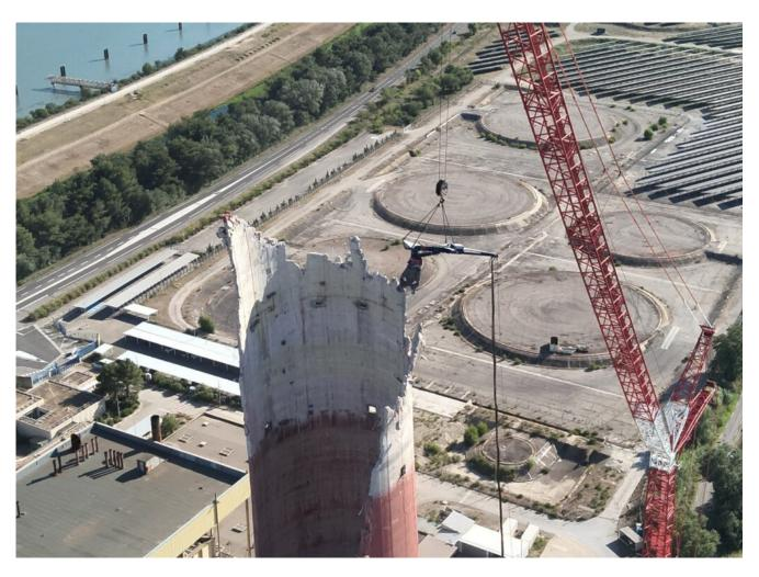
Les travaux sont réalisés par la pince mécanique suspendue à la grue mobile positionnée à côté de la cheminée et alimentée par une pelle hydraulique. L'opération est télécommandée grâce à un système de caméras depuis la cabine de la grue permettant de réaliser l'opération à distance dans des conditions de sécurité.
