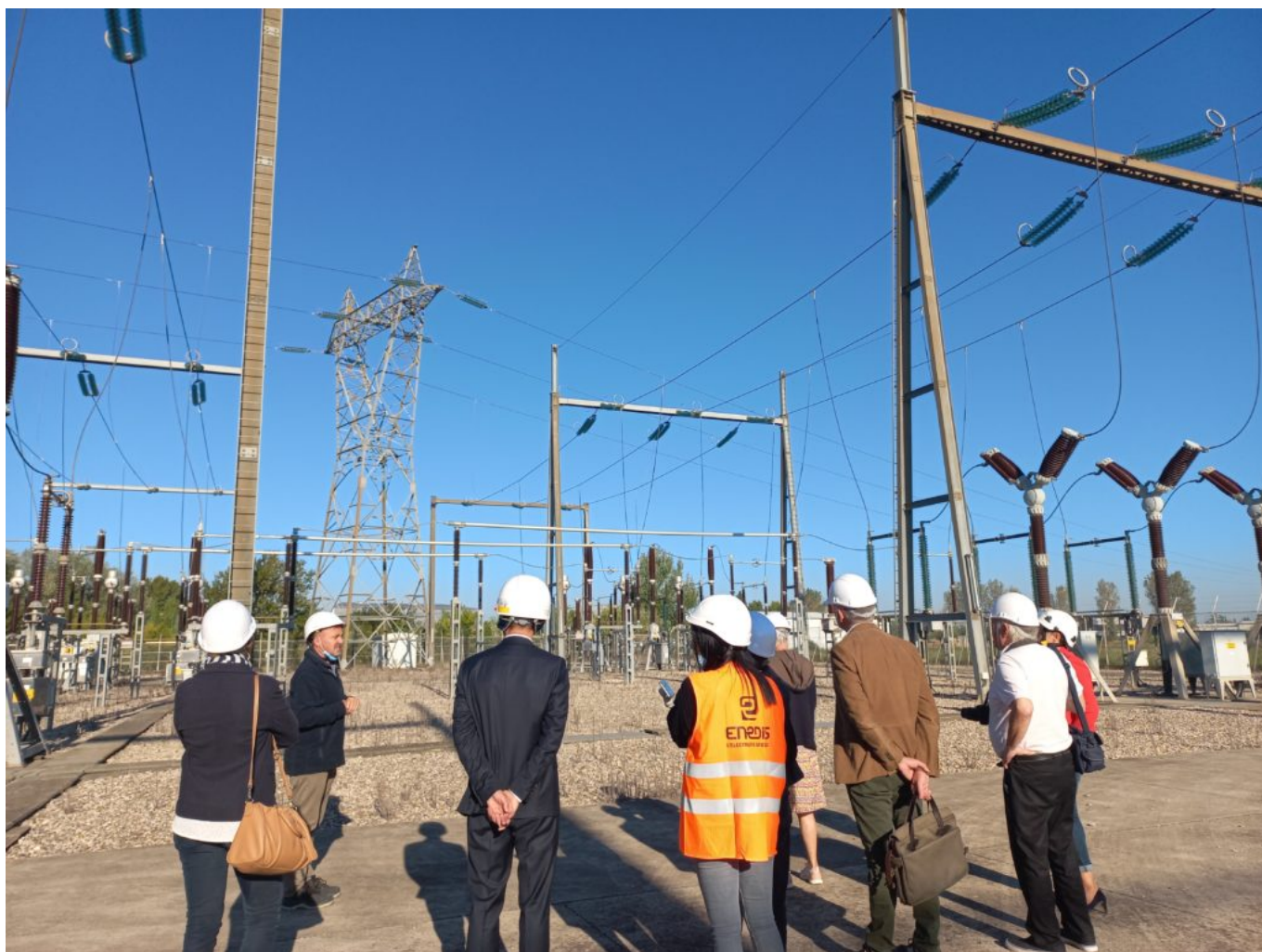
Visite de chantier. Crédit photo: Enedis
