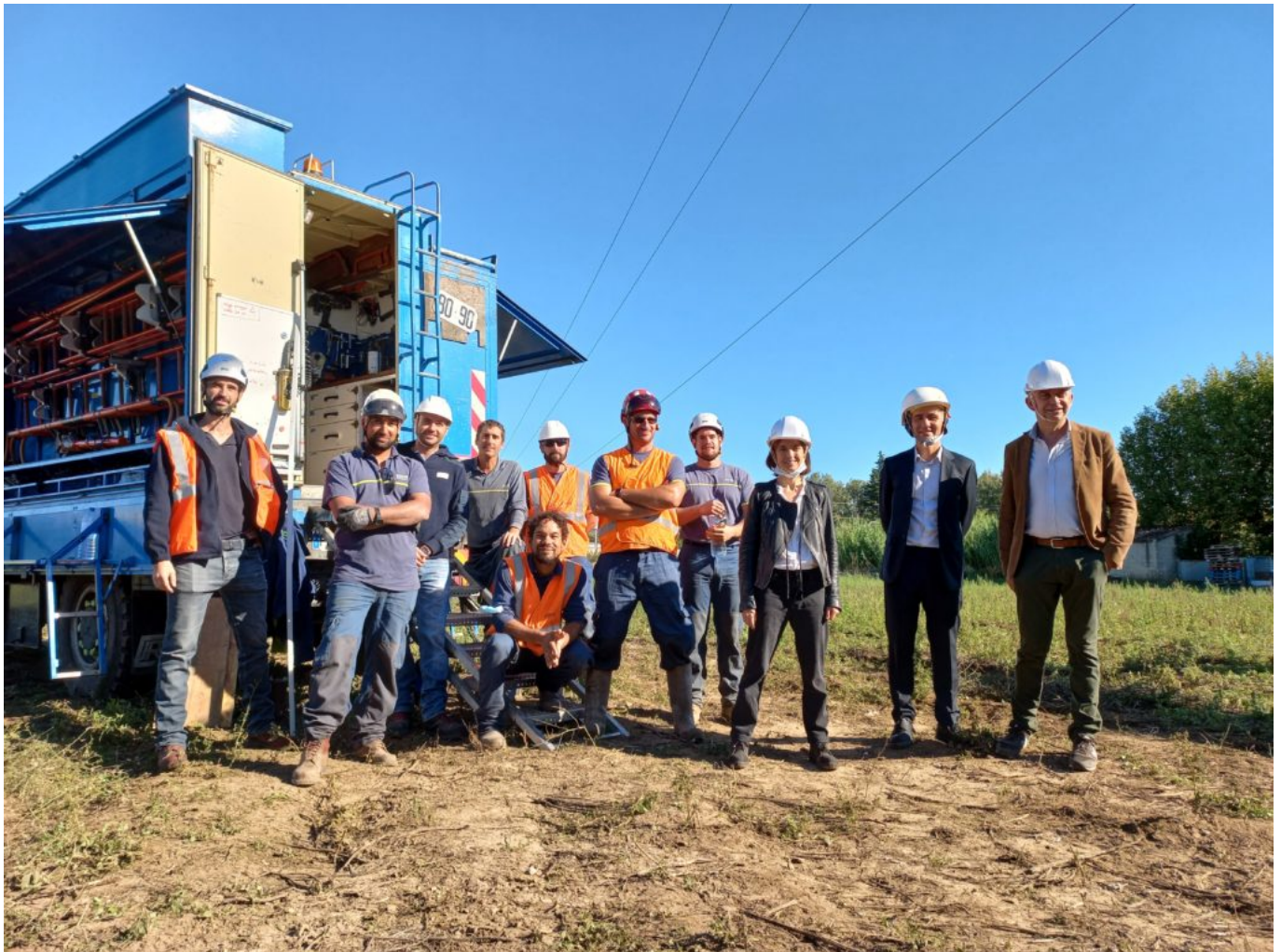
Visite de chantier Travaux sous Tension à Velorgues. Crédit photo: Enedis
