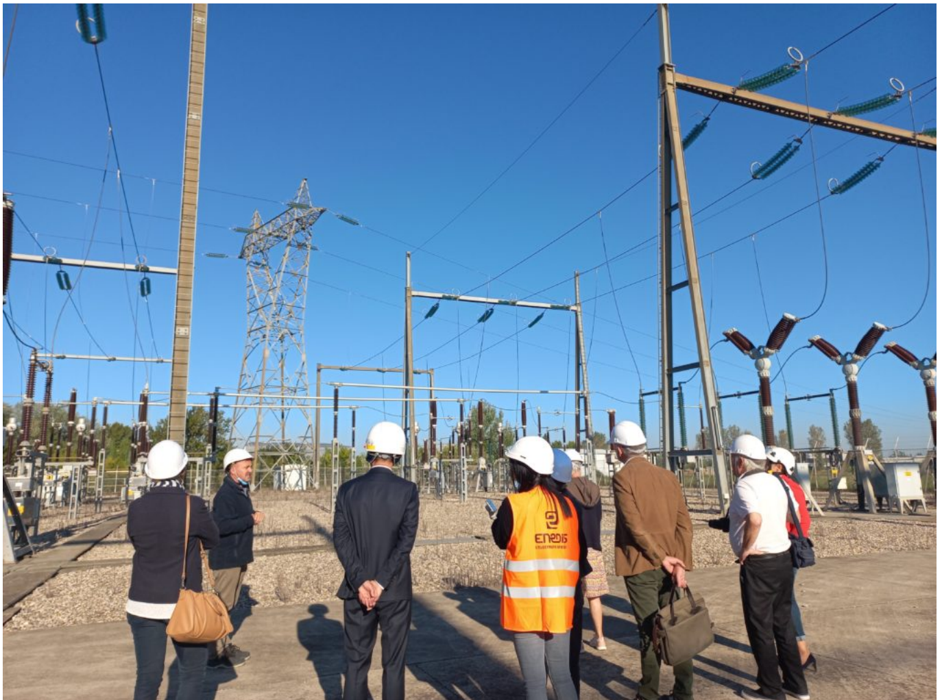
Visite de chantier. Crédit photo: Enedis
