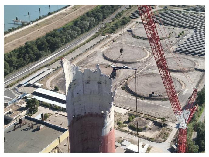
Les travaux sont réalisés par la pince mécanique suspendue à la grue mobile positionnée à côté de la
