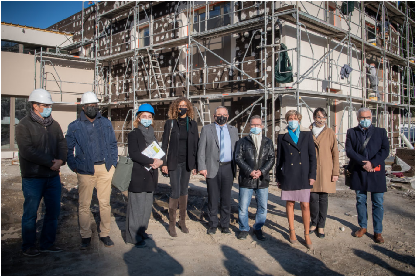
Visite de chantier. Crédit photo : Grand Avignon
