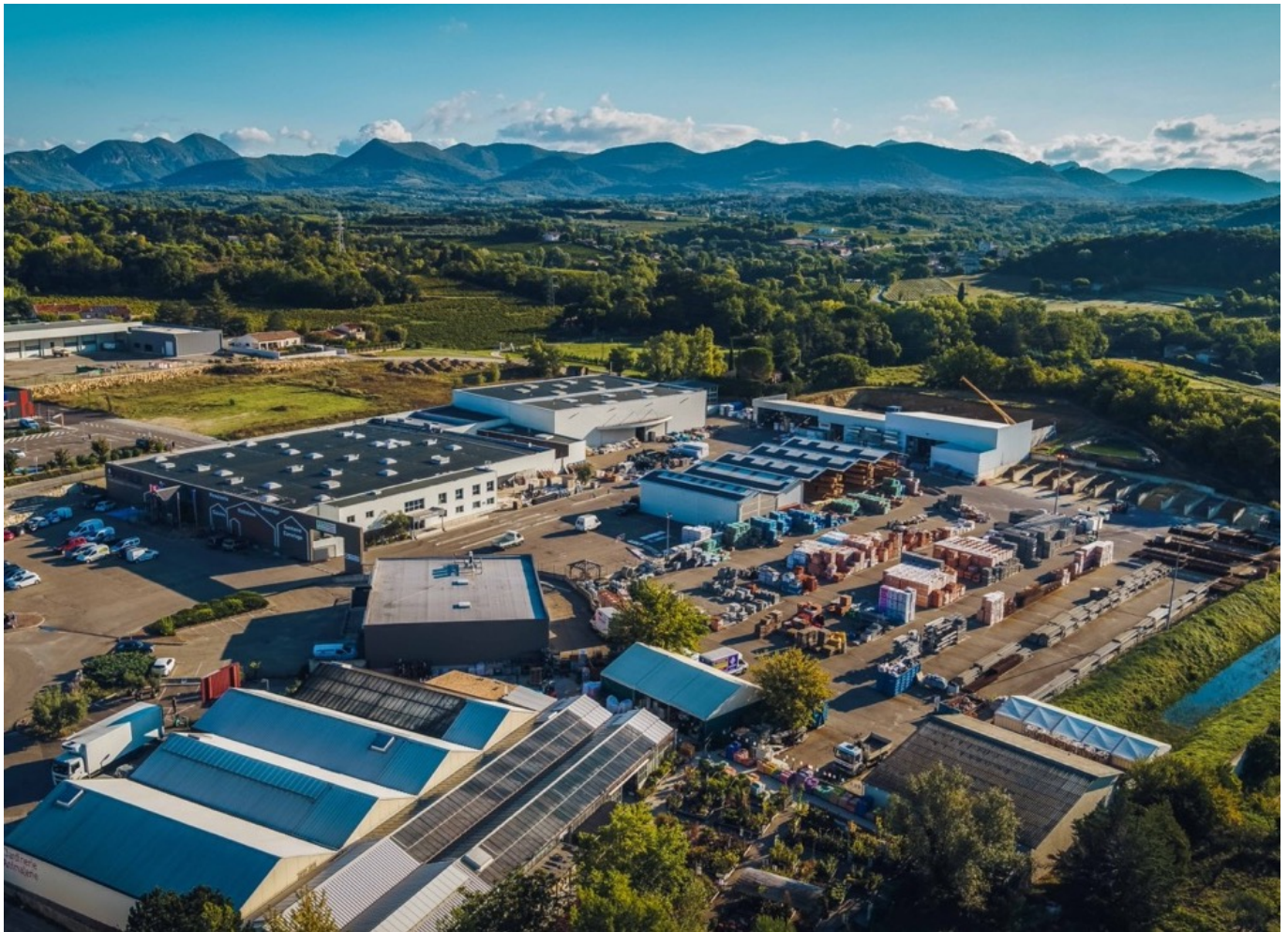
Le site Augier, à Vaison-la-Romaine. ©Augier
