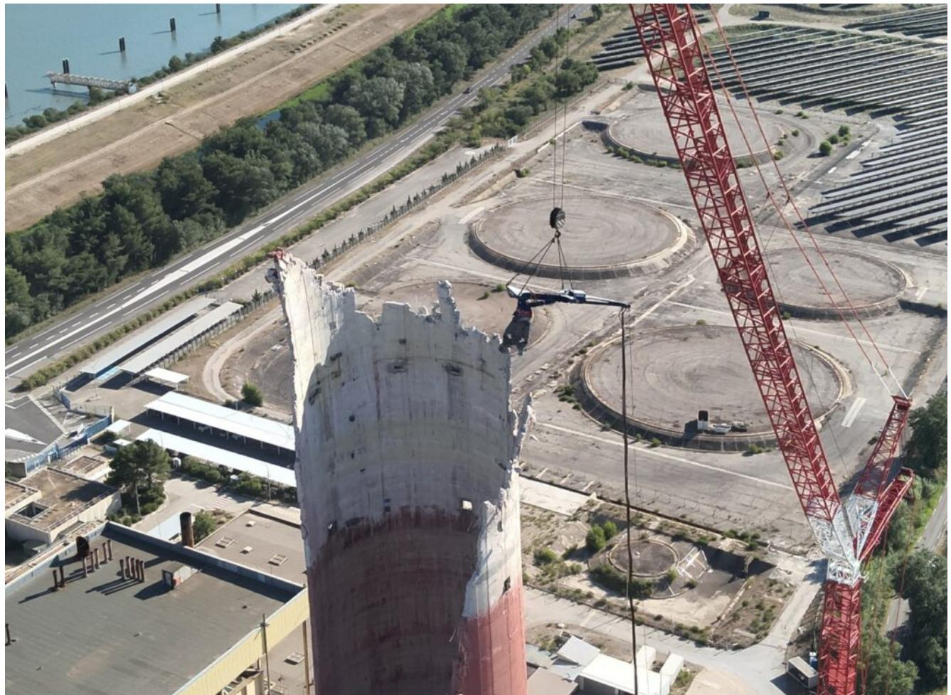
Les travaux sont réalisés par la pince mécanique suspendue à la grue mobile positionnée à côté de la cheminée et alimentée par une pelle hydraulique. L'opération est télécommandée grâce à un système de
