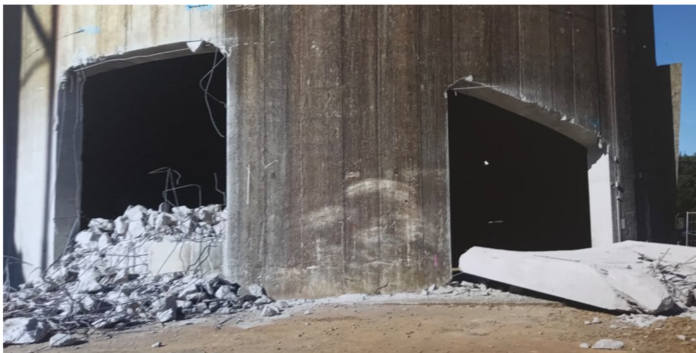
Le pied de la cheminée avait été en partie affaibli grâce à plusieurs percements (photo du dessus). Des explosifs avaient été également répartis dans les parties pleines (photo ci-dessous).
