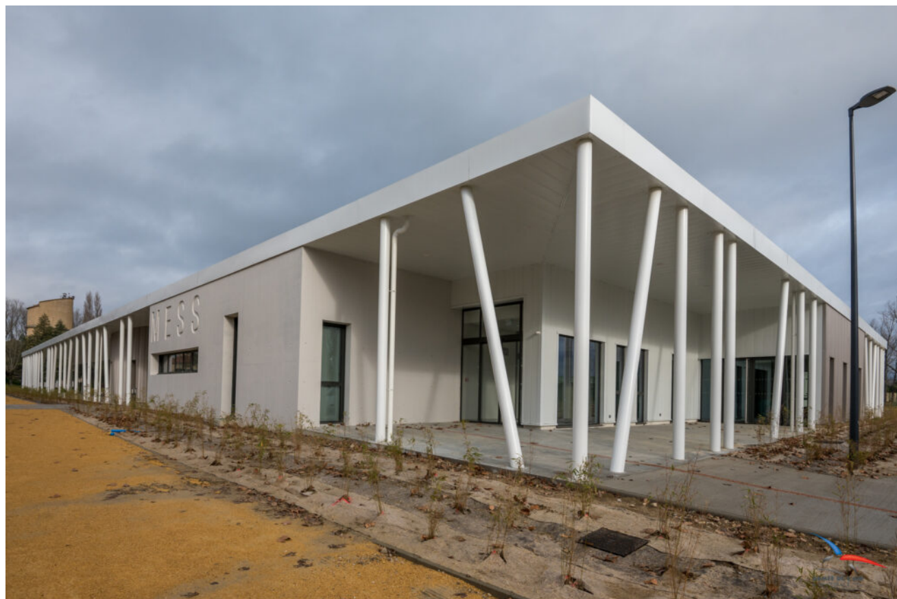
Le nouveau mess de la BA115 est en cours d'achèvement. ©Armée de l'air et de l'espace
