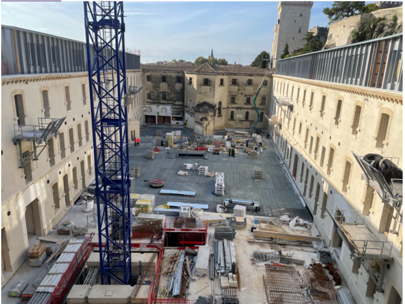
La Cour des Doms en cours de construction et rénovation
