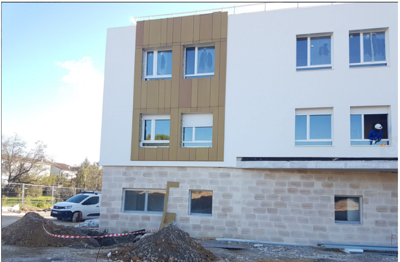
Ehpad de Bollène, enduits et isolation thermique, Copyright Benedetti SA
