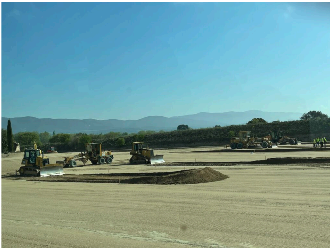
Exercices de terrassement
