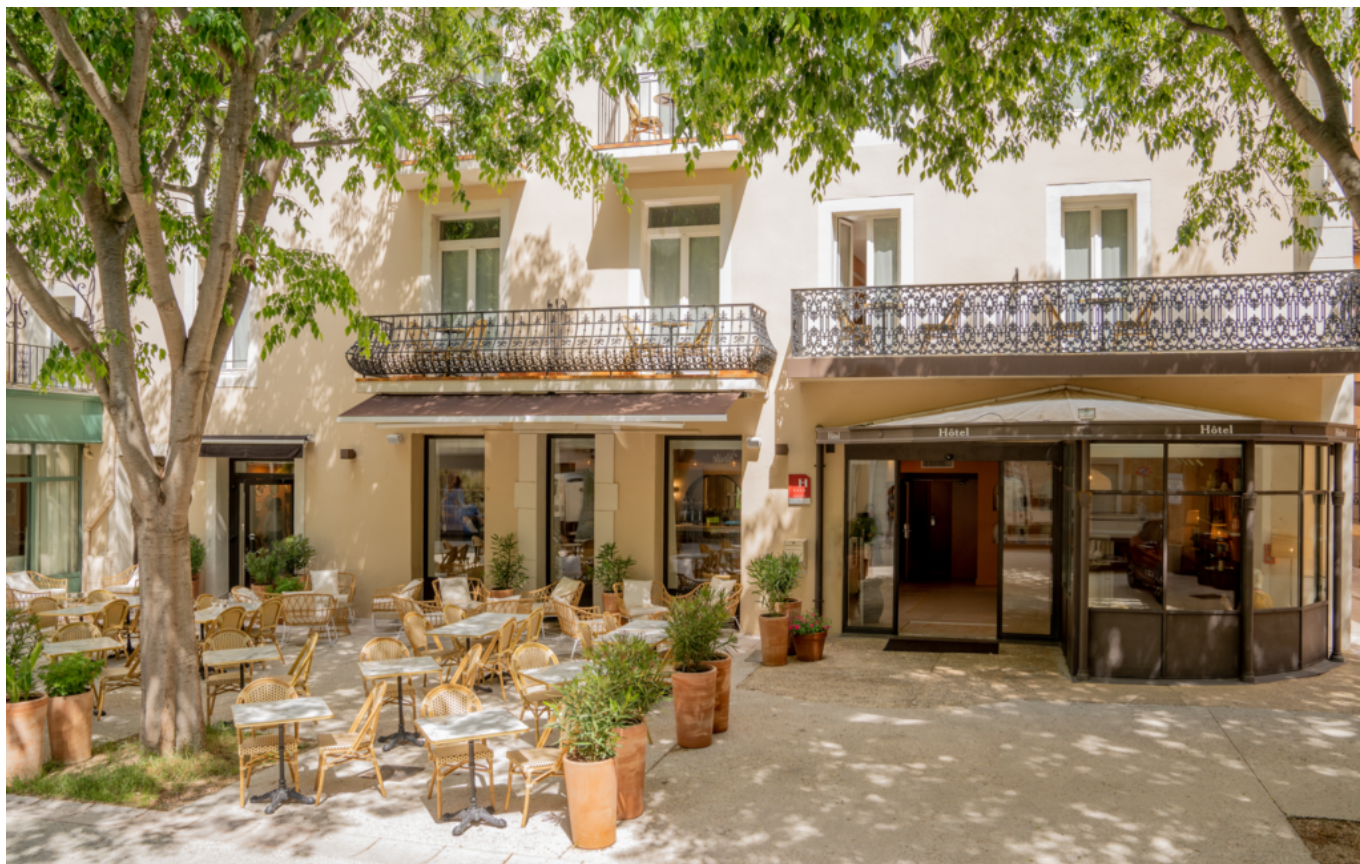
Façade Grand Hôtel d'Orange
