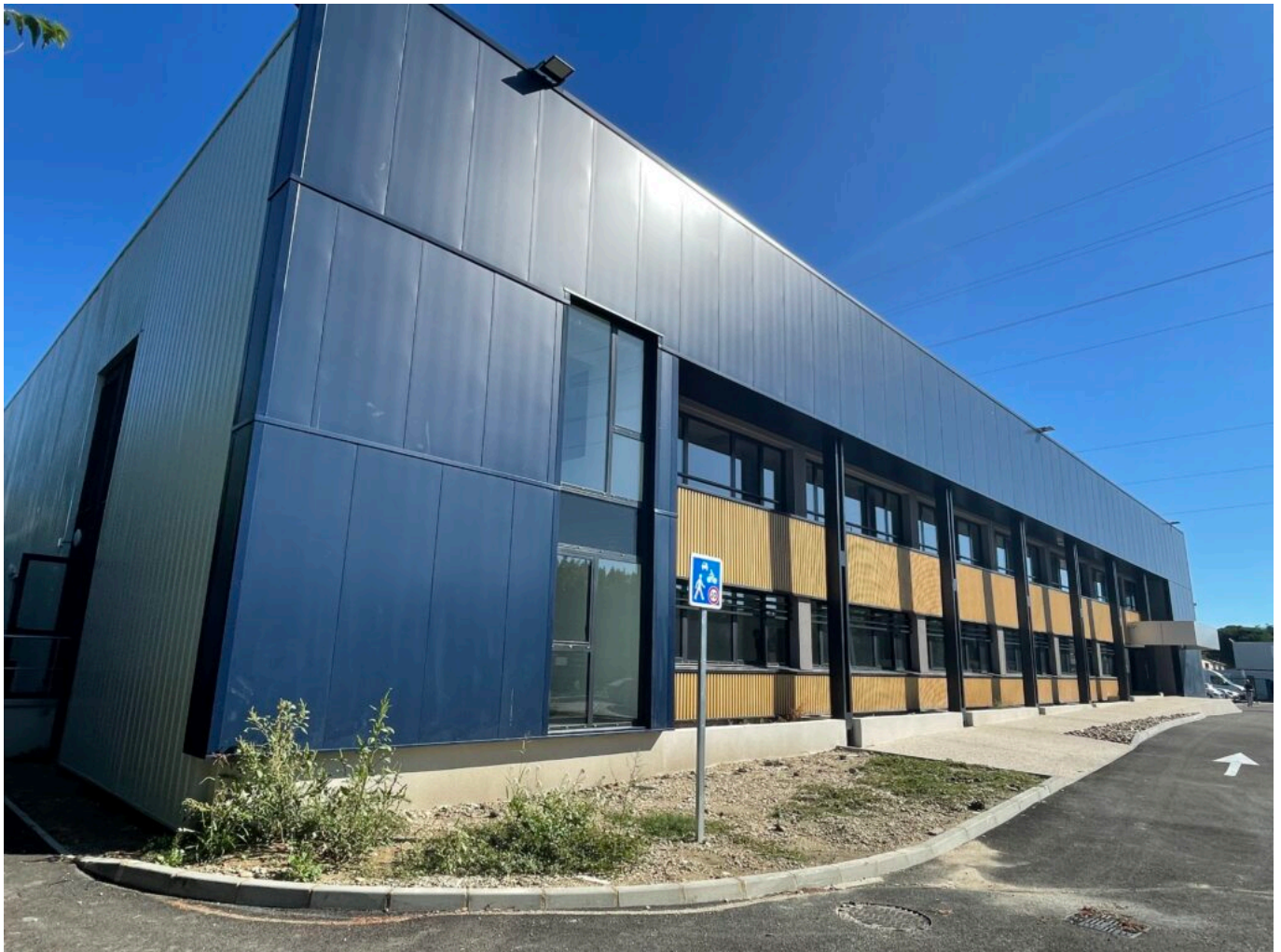
Montéa Bâtiment A, Courtine, Copyright MMH
