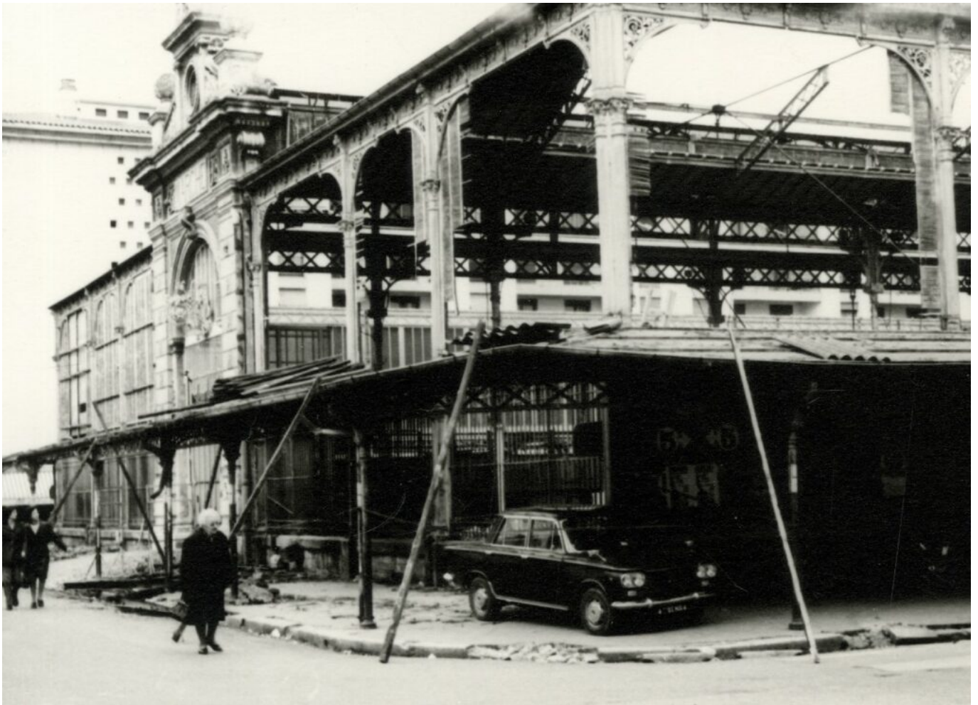
Les Halles en cours de démolition en 1972. Fond privé. Archives municipales. Anonyme. Photographie, 13X18
