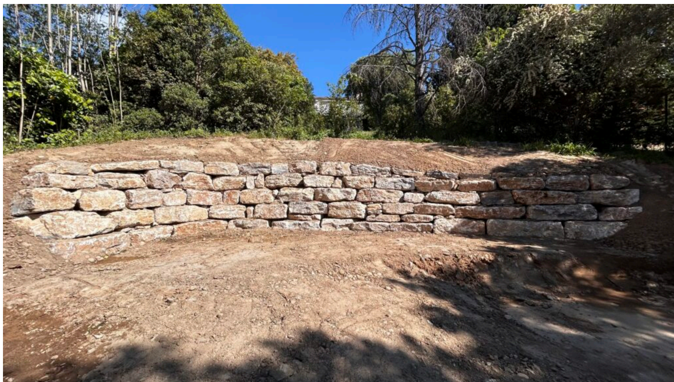
Retenue de terre en pierres Copyright GM terrassement
