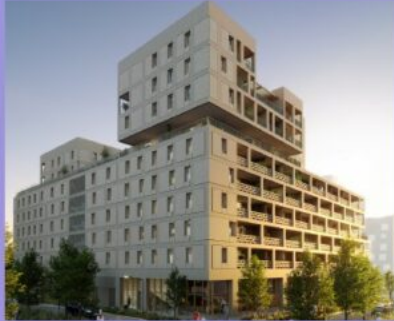
Les Fabriques - Marseille (13) 49 logements // Livraison 2027
