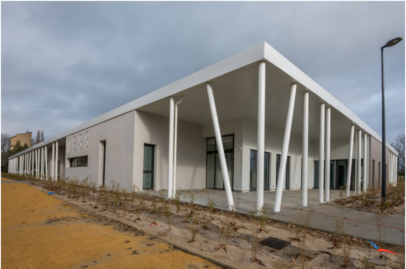
Le nouveau mess de la BA115 est en cours d'achèvement. ©Armée de l'air et de l'espace
