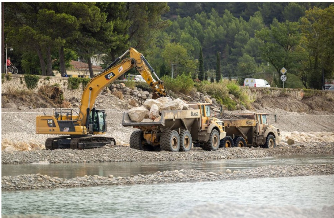
Travaux sur la digue de la Durance Copyright SMAVD
