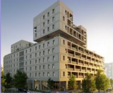
Les Fabriques - Marseille (13) 49 logements // Livraison 2027
