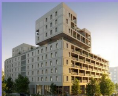
Les Fabriques - Marseille (13) 49 logements // Livraison 2027
