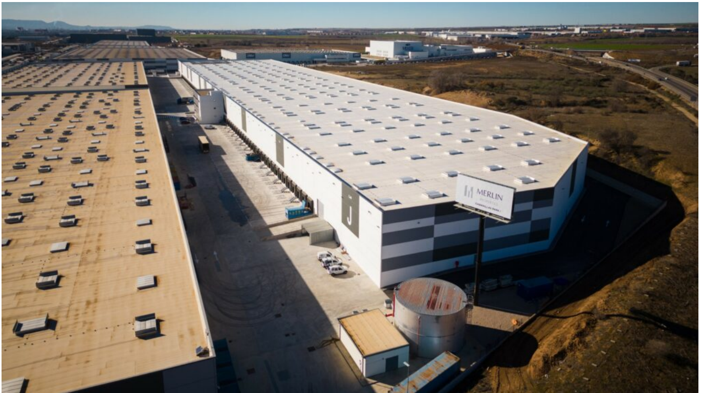
Nouvel entrepôt logistique pour MERLIN Properties à Madrid © GSE
