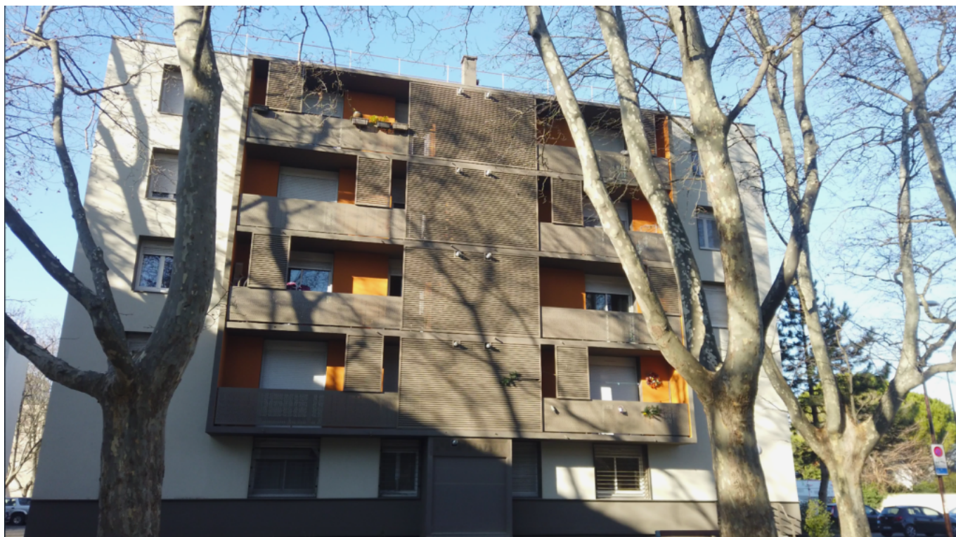
Réhabilitation de Saint-Chamand
