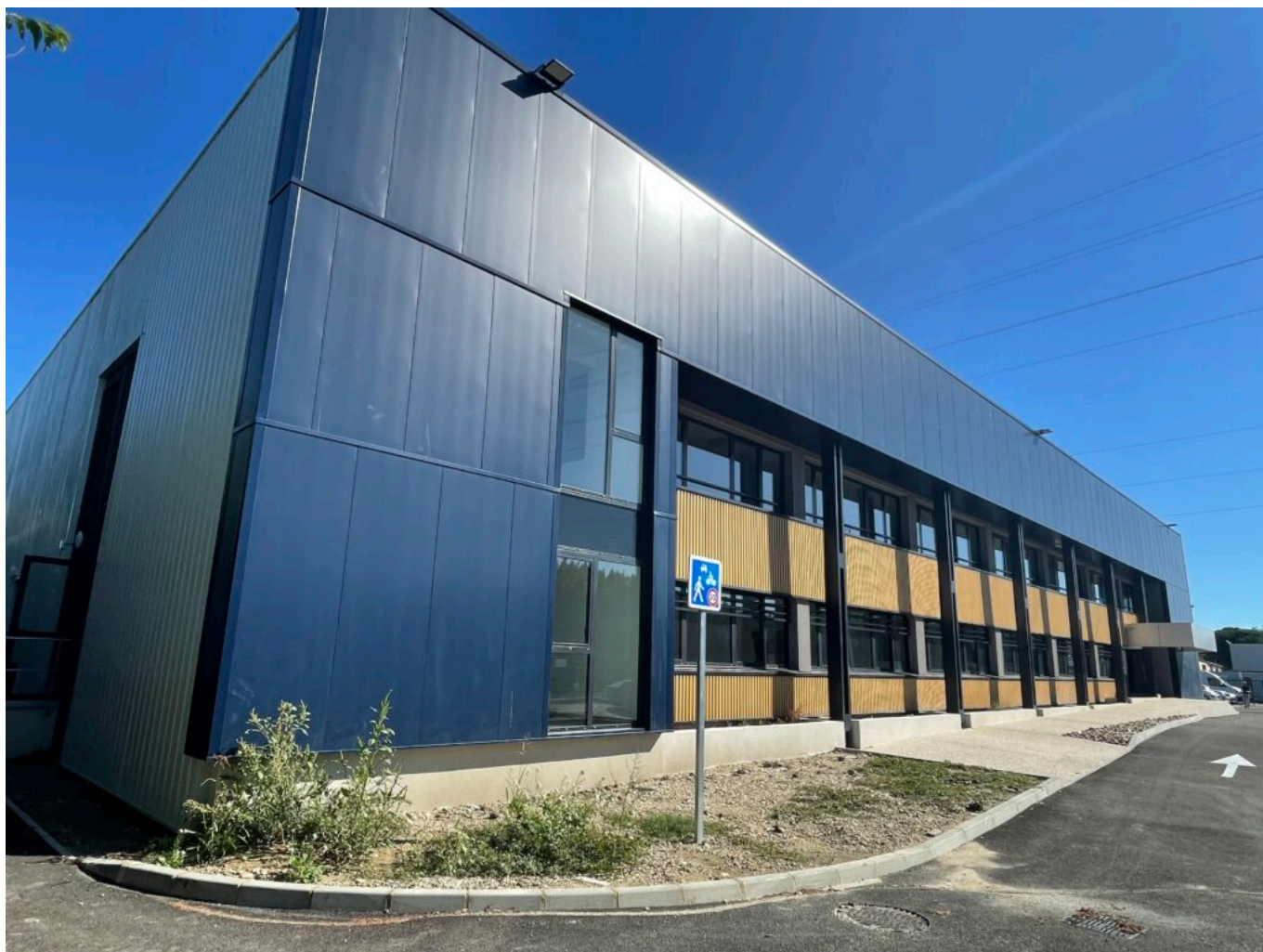
Montéa Bâtiment A, Courtine, Copyright MMH
