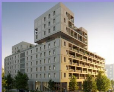
Les Fabriques - Marseille (13) 49 logements // Livraison 2027
