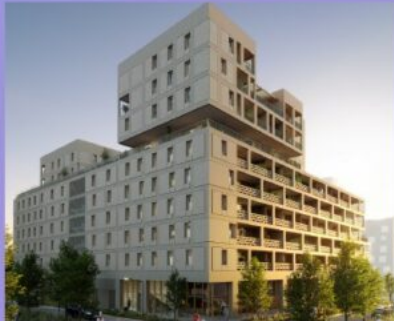
Les Fabriques - Marseille (13) 49 logements // Livraison 2027
