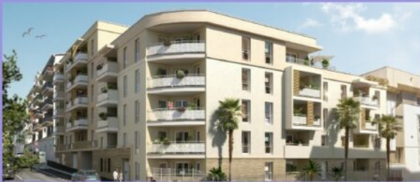
Rosa Nova - Toulon (83) 25 logements // Livraison 2028
