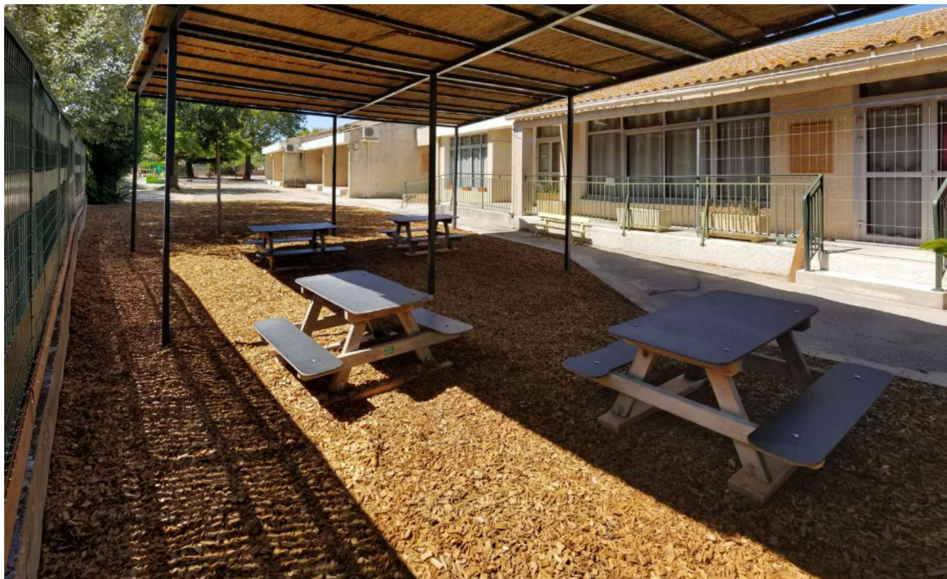
Ecole maternelle des Vallades Copyright l'Isle-sur-la-Sorgue
