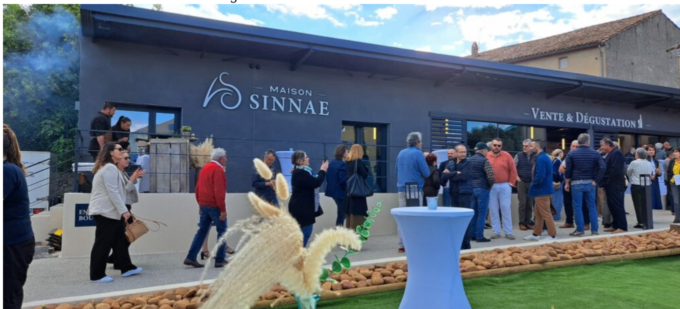
Le caveau et le pôle de réception
