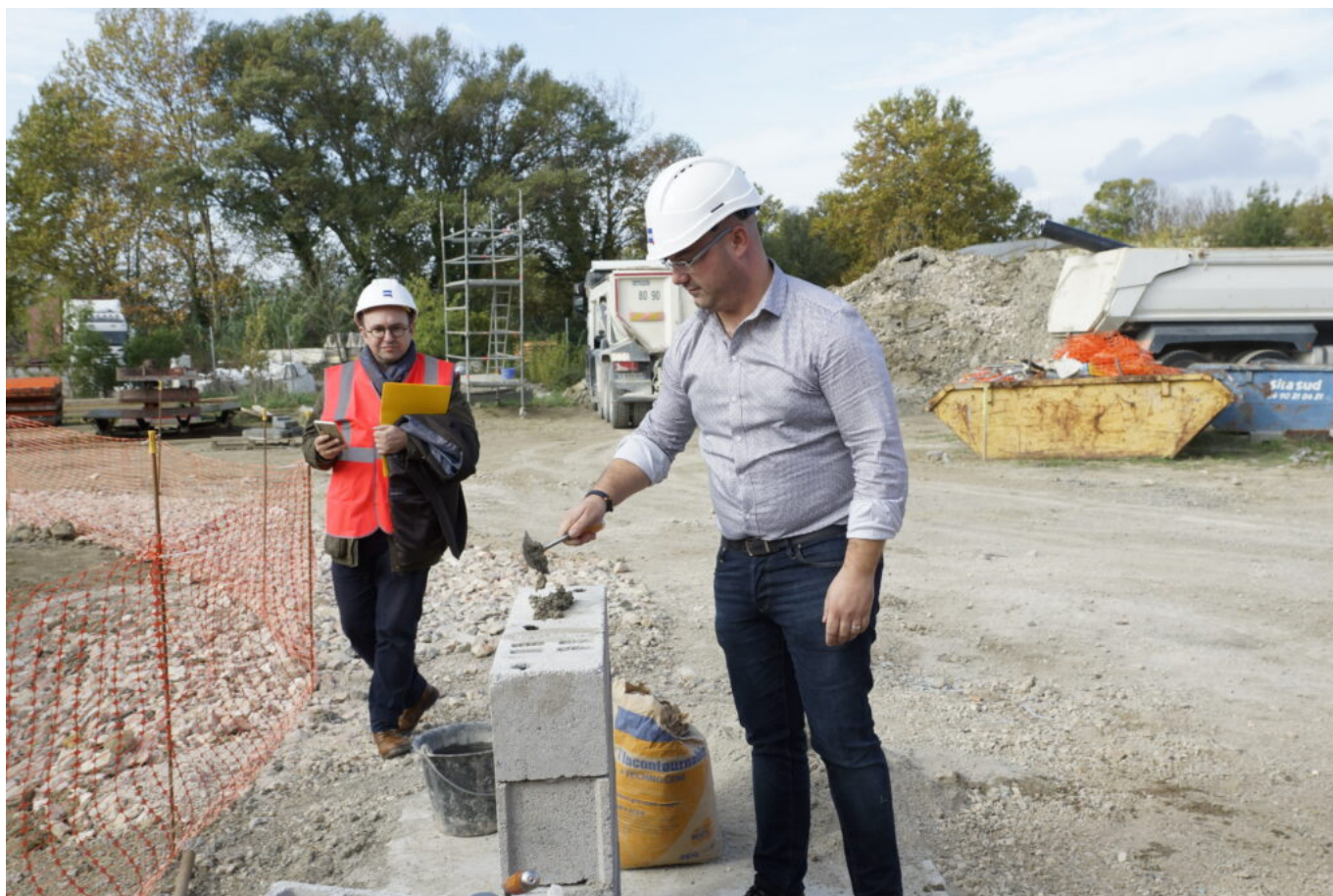
Yann Bompard, maire de la ville d'Orange, pose la première pierre de la nouvelle station d'épuration de Jonquières © DR
