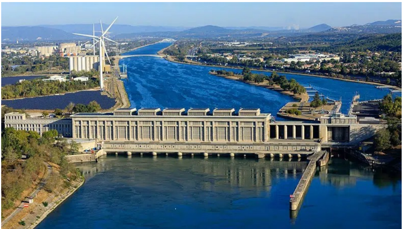
Centrale hydroélectrique de Bollène . ©CNR Bollène
