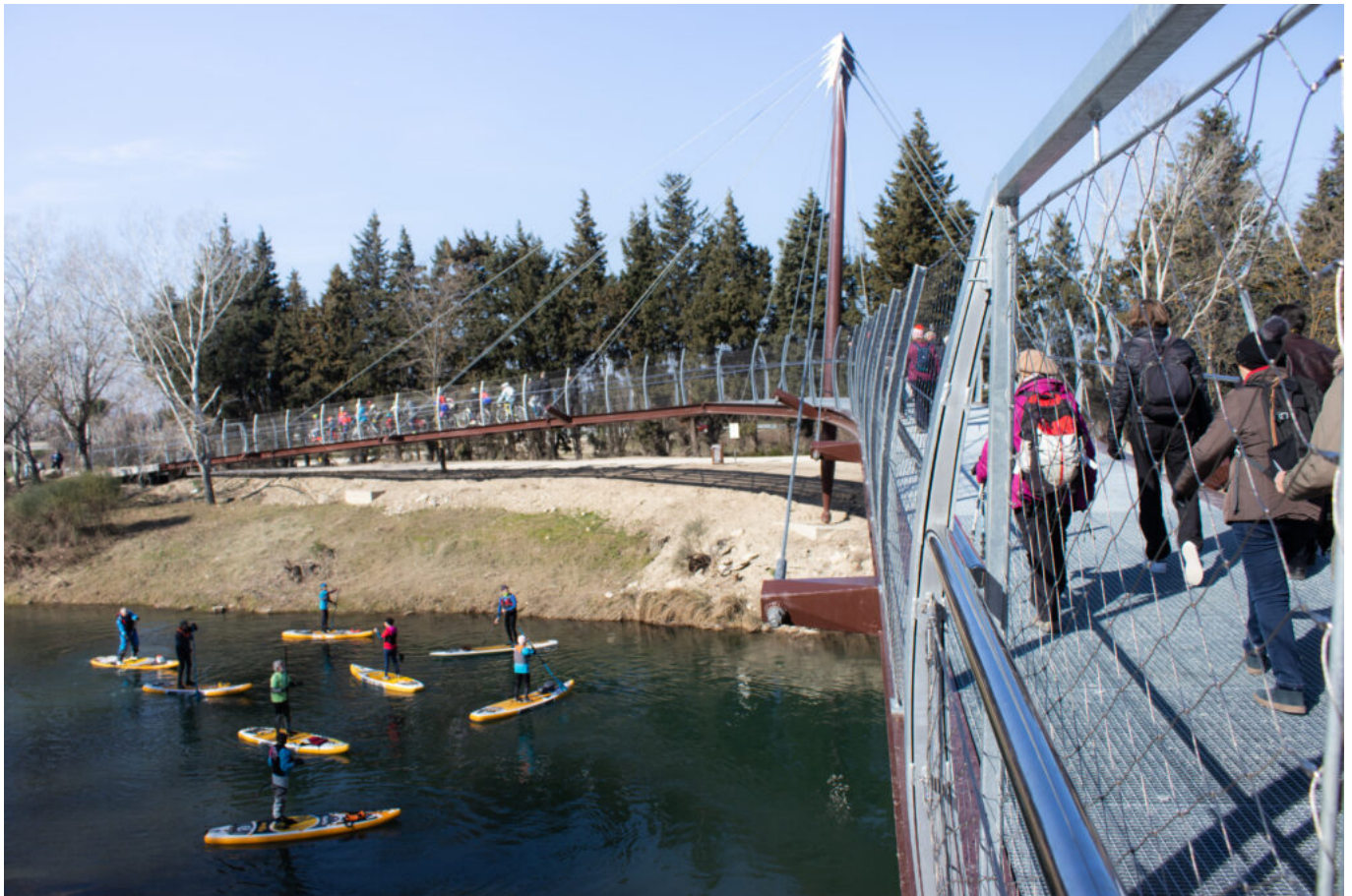
La passerelle himalayenne de Sorgues enjambant l'Ouvèze
