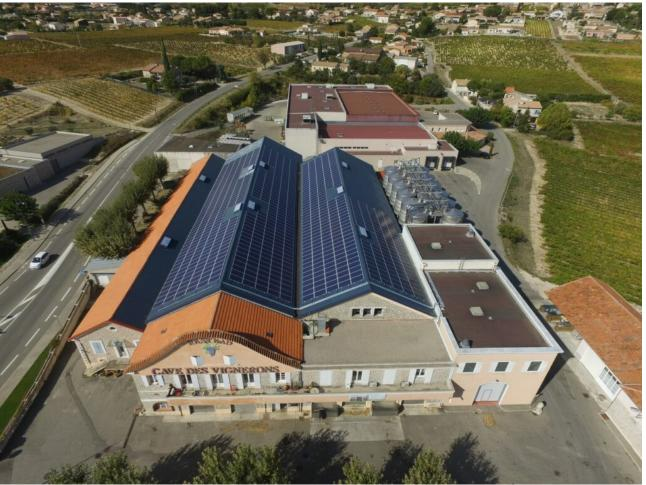
L'avignonnais Sefco a réalisé la rénovation de la cave viticole de Rasteau en intégrant notamment une centrale photovoltaïque en toiture d'une capacité de 223kWc. © Sefco
