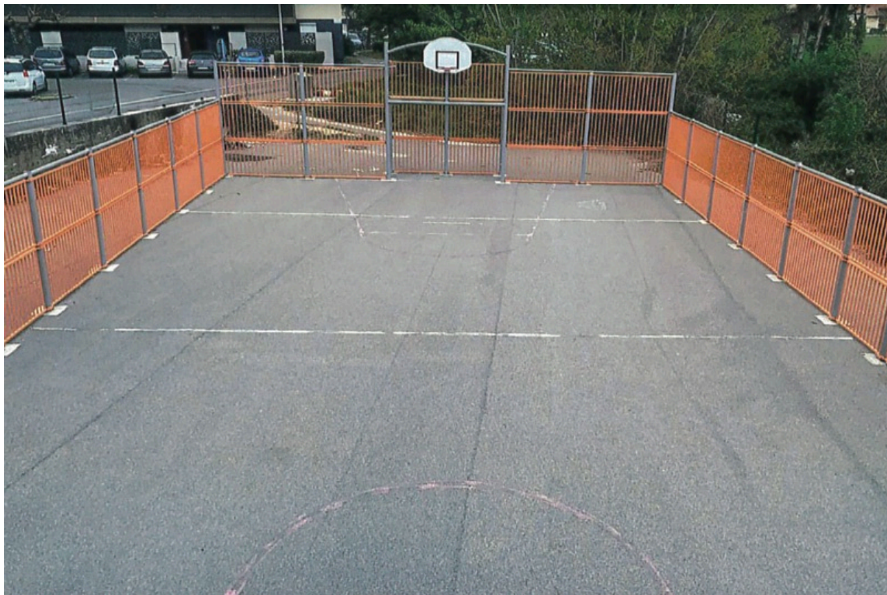
• Avant les travaux
