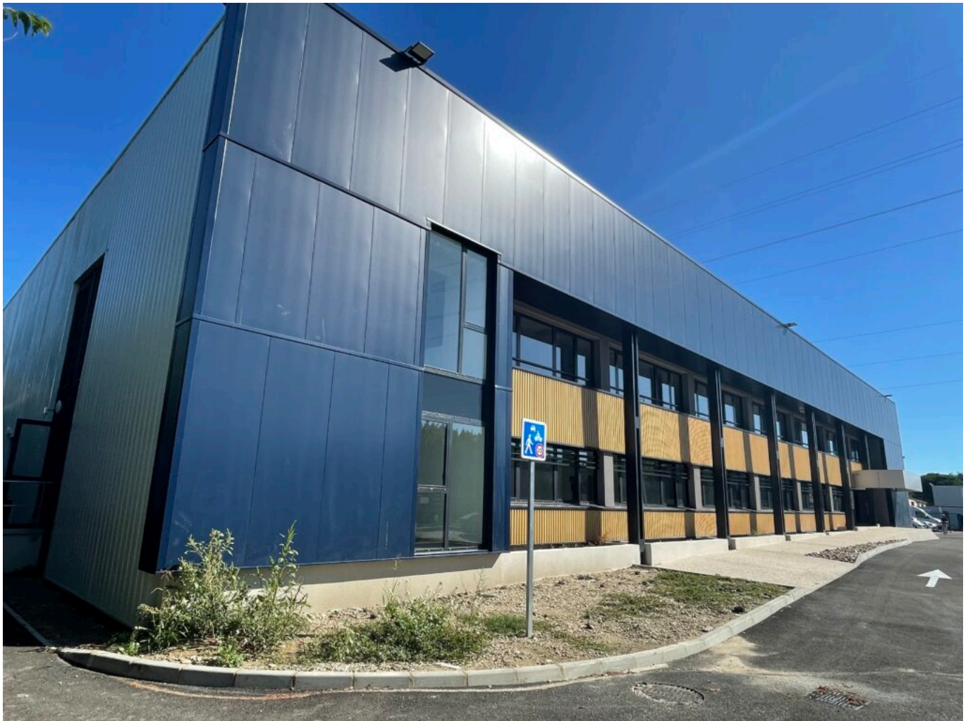
Montéa Bâtiment A, Courtine, Copyright MMH
