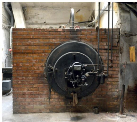
Au sous-sol, réside encore l'installation technique : une chaufferie composée de trois chaudières à charbon, puis à fuel
