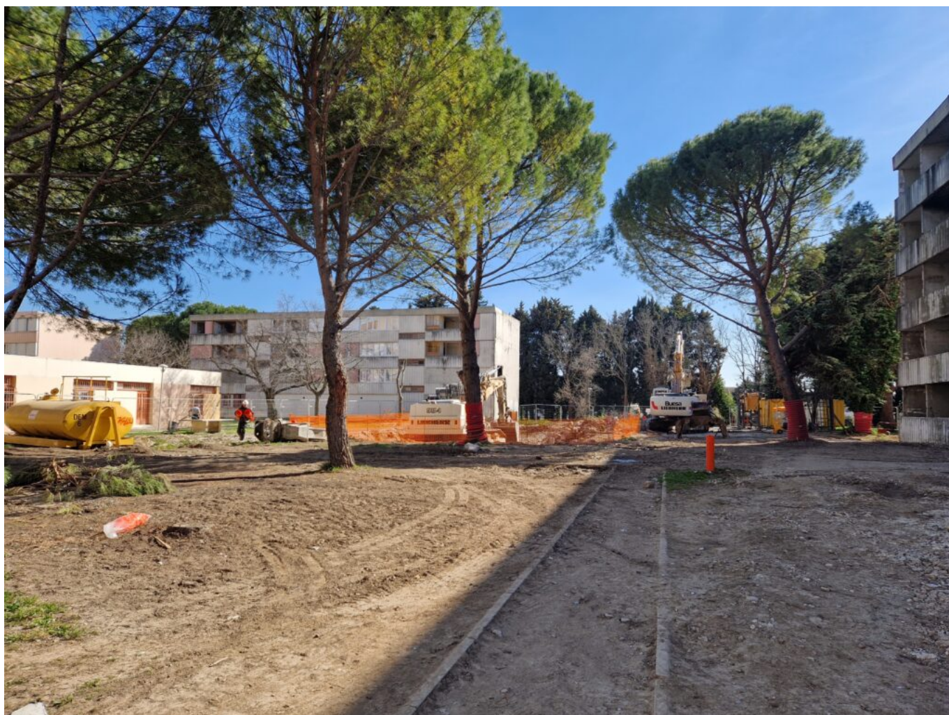
Le chantier en cours
