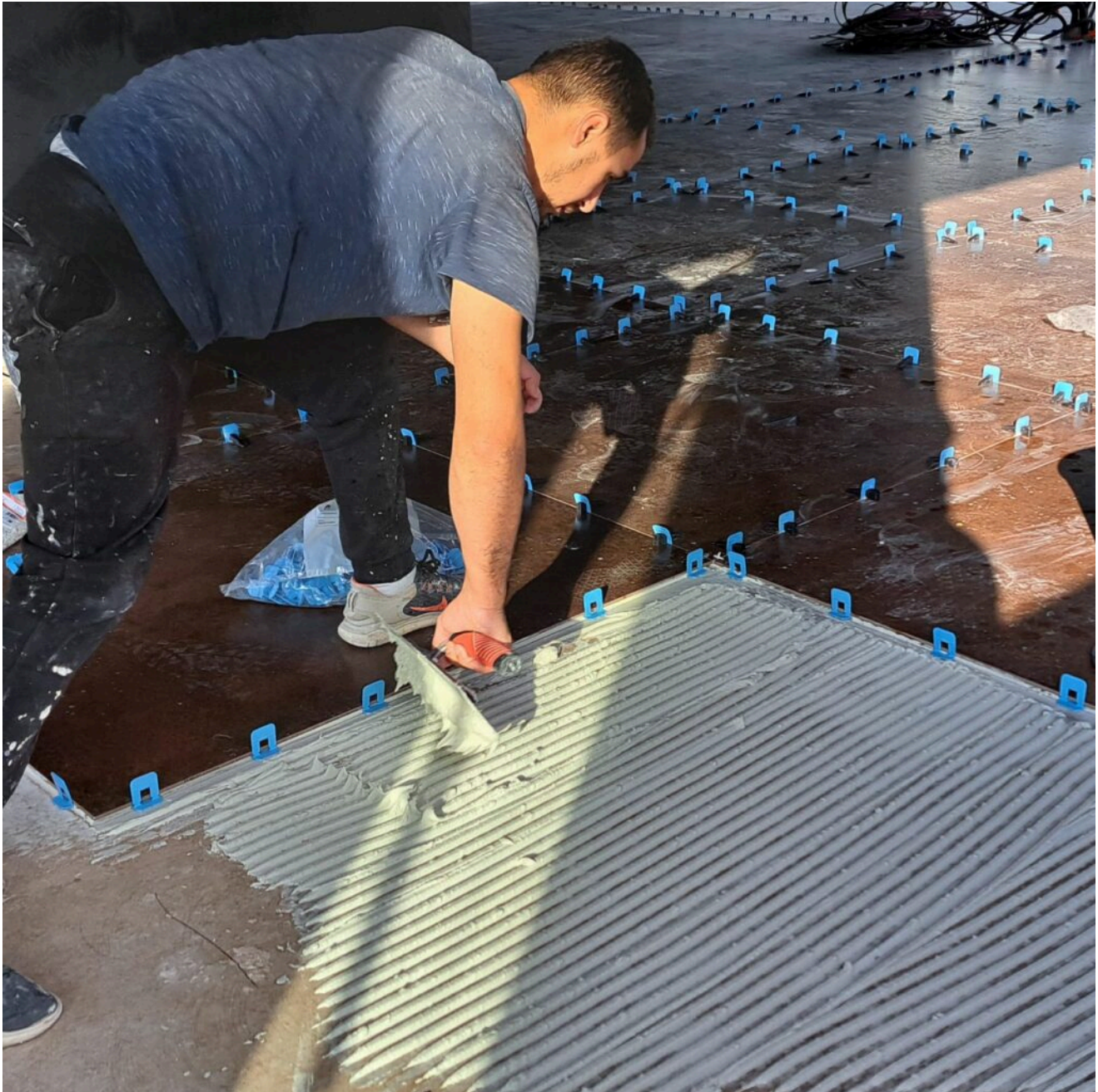
Pose du carrelage ©AB/L'Echo du Mardi
