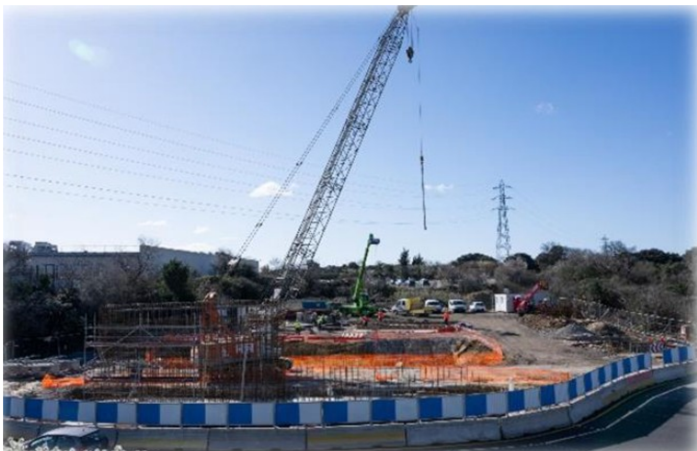
Franchissement de la route de Jonquières Copyright Département de Vaucluse
