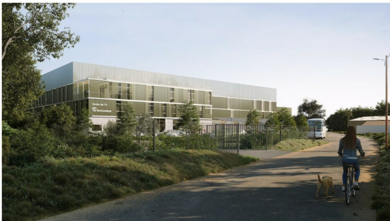
Vue du projet depuis le chemin de Capeau – AT&E Architectes
