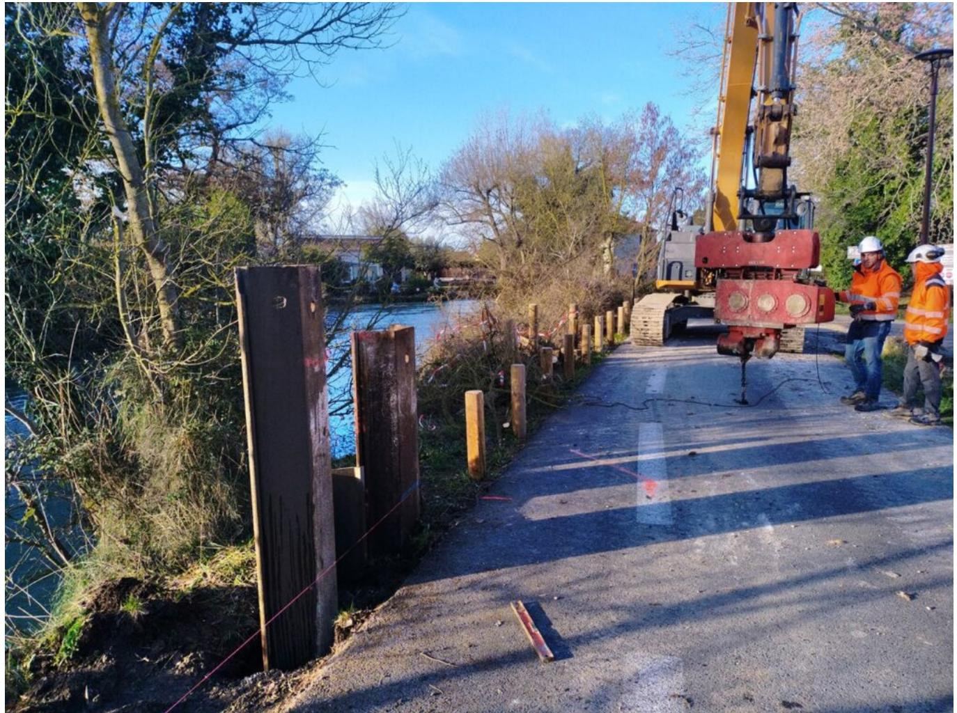
Le [Syndicat Mixte du Bassin des Sorgues \(SMBS\)](#) a engagé des travaux d'urgence de soutènement sur l'Avenue du Partage des Eaux à L'Isle-sur-la-Sorgue pour préserver l'intégrité de la chaussée et garantir la sécurité des usagers.
