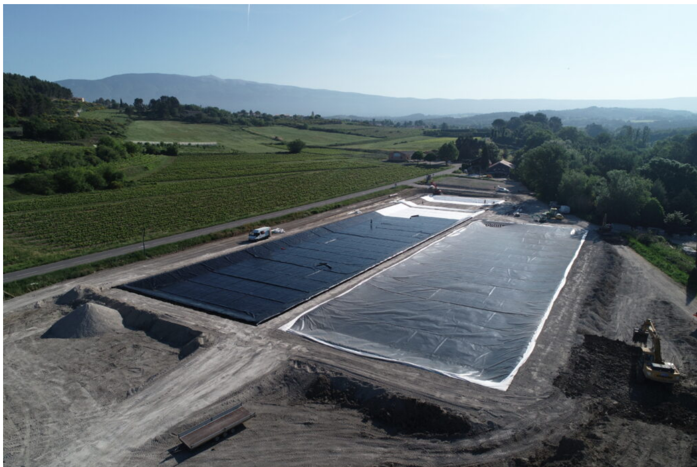
La station d'épuration des eaux usées lors des travaux avant qu'elle ne soit finalisée
